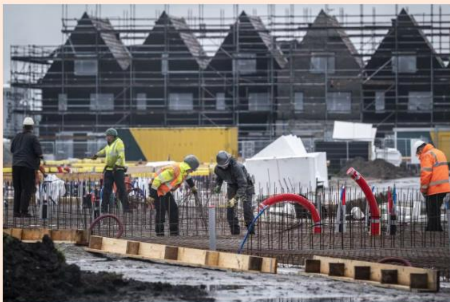
Nieuwbouwwijk De Zeilen in het Groningse Meerstad in aanbouw. Foto: Kees van de Veen/ANP
