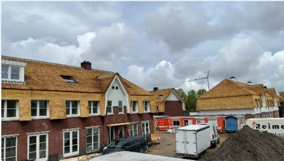
In aanbouw zijnde milieuvriendelijke Boltonwoningen in het dorp De Kwakel. Foto: Bolton Groep
